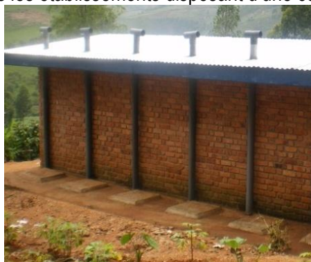
Vue extérieure d'une VIP, ses dalles de vidange et ses tuyaux d'aération et de ventilation à l'arrière
