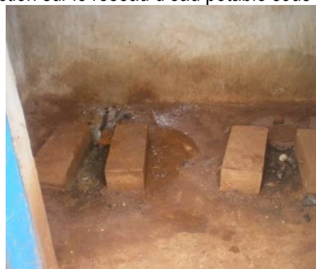
Intérieur d'une cabine de défécation avec utilisation simultanée des fosses
